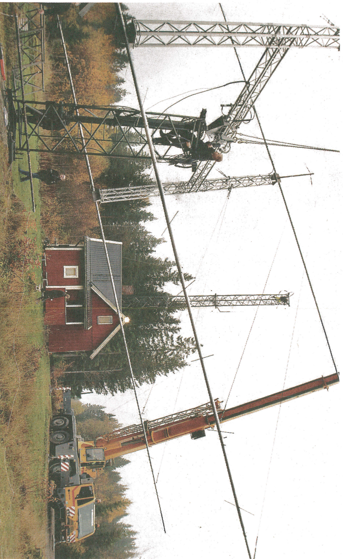
Antennen monteras ner från sin provisoriska plats. I den höga masten sitter redan Per Larsson och väntar för att kunna förankra antennen i masten.
